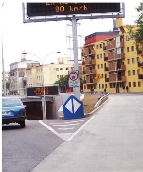
Los hitos de vértice son dispositivos utilizados para indicar la existencia de un vértice de separación de flujos que circulan en un mismo sentido, como se muestra en la Figura 7.3-3.
